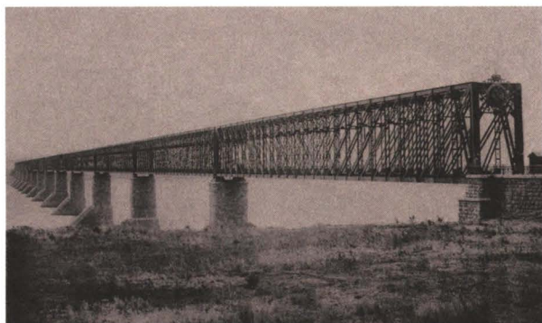
Александровский железнодорожный мост через Волгу в районе Сызрани. Построен по проекту Н.А. Белелюбского
