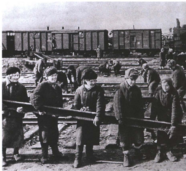
Замена рельсов на железнодорожной станции. Волжская рокада. 1942 г.
